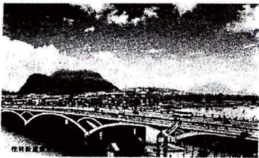
图 1 桂林新建解放桥照片
