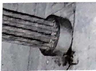
图 3 HVM15A-2 锚固区形貌
