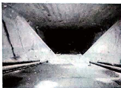
图10 新浏河桥箱梁内的体外索形貌
