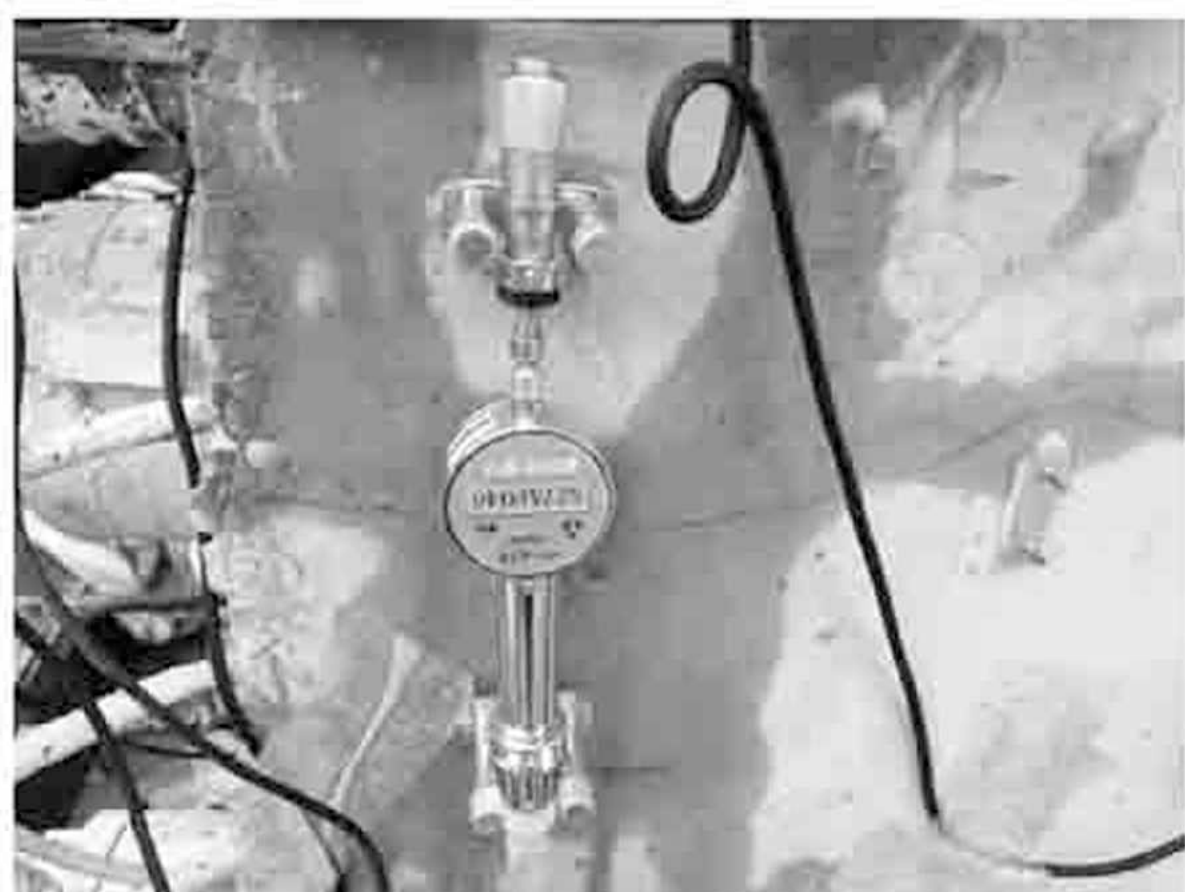
图12 中腹板3号钢束对应处纵裂缝
