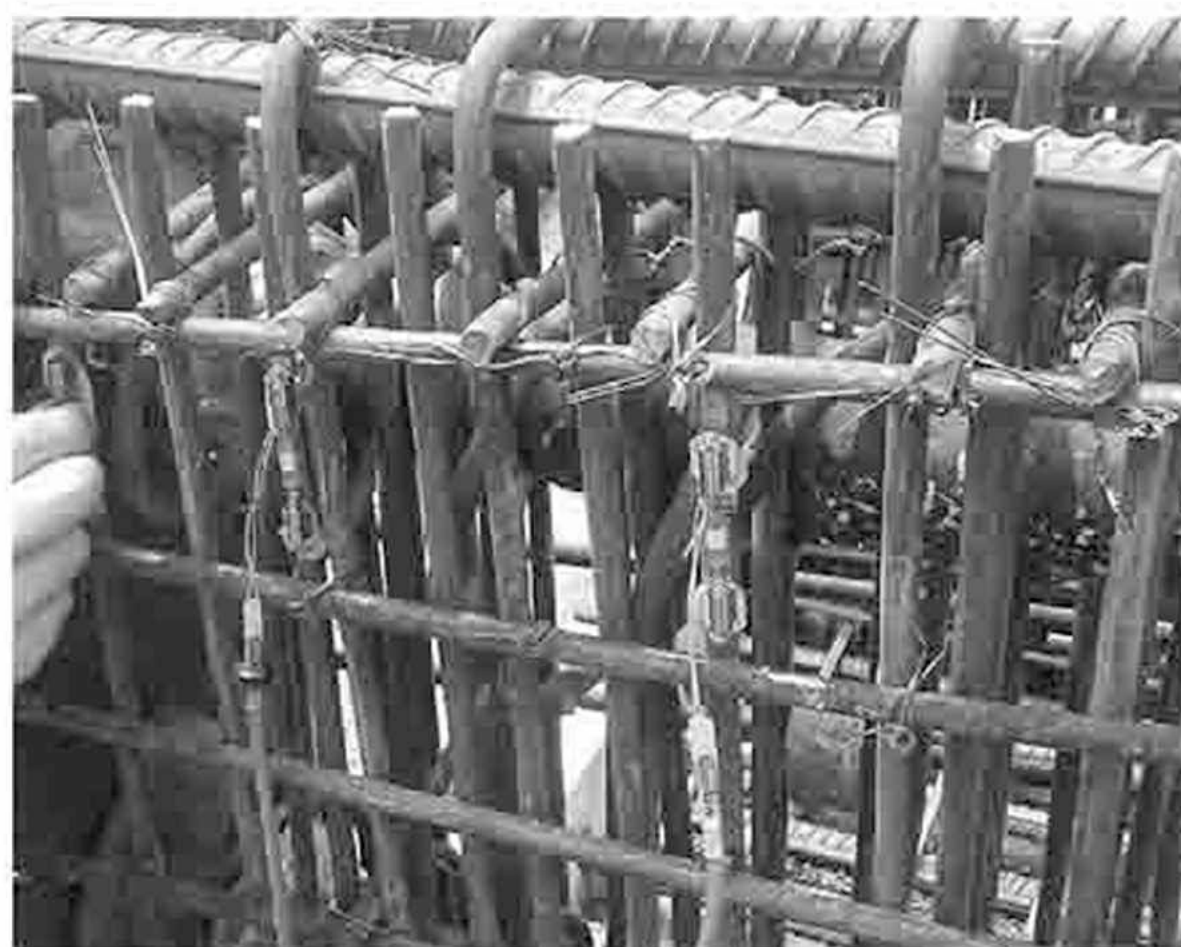
图10 锚下应变器安装
