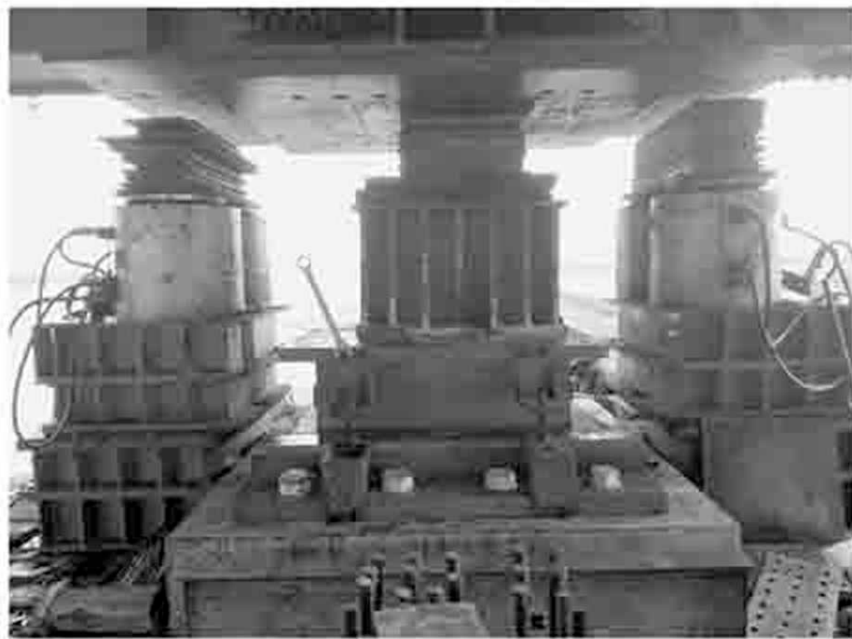
图2 左桁千斤顶现场布置图
