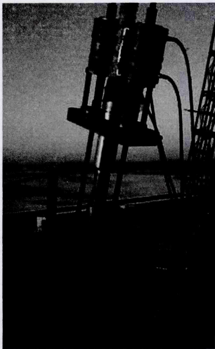
图15 张拉系统安装
