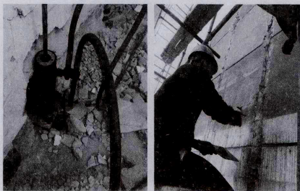
(e) 预应力筋的张拉施工
