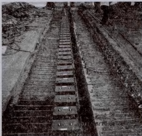
图1 定位锚固螺栓和多向变位系统
