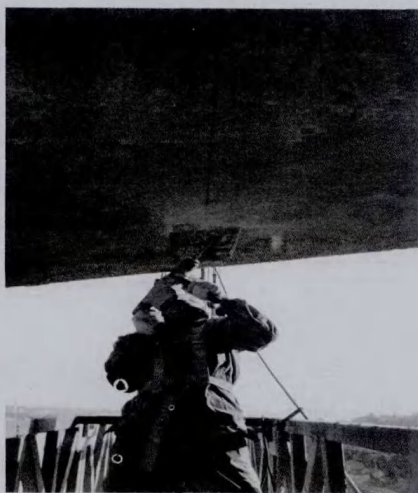
图5 固定端锚头开槽
