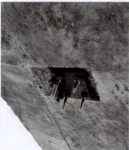
图7 固定端锚具安装
