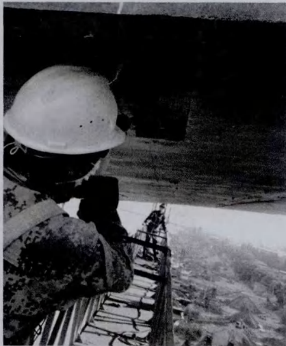
图4 张拉端锚头开槽
