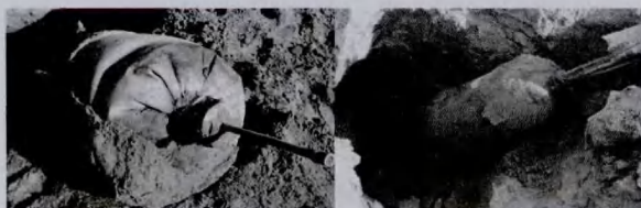
图15 从土中挖出的承压式囊袋扩体
