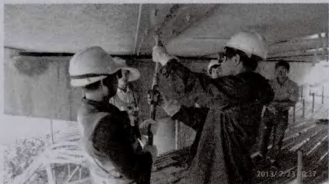
图11 压力注胶现场图
