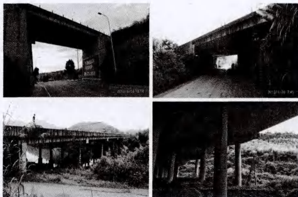
图1 工程沿线施工桥梁现场照
