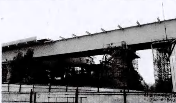
图43 顶推到位的右幅桥梁
