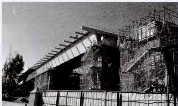
图42 顶推中的桥梁
