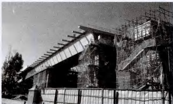
图42 顶推中的桥梁
