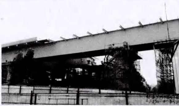
图43 顶推到位的右幅桥梁
