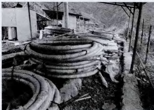
图7 锚索现场堆放
