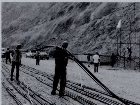
图17 YJM15让压分散型锚索的施工
