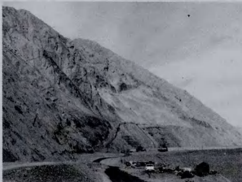
图16 边坡除险加固概况
