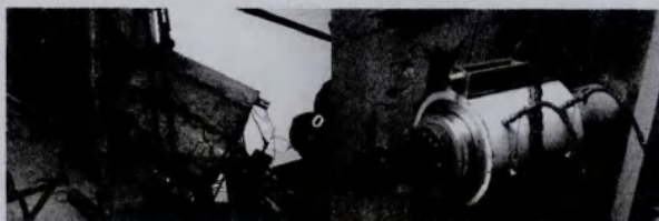
图6 YCW500H-250/300千斤顶在施工中
