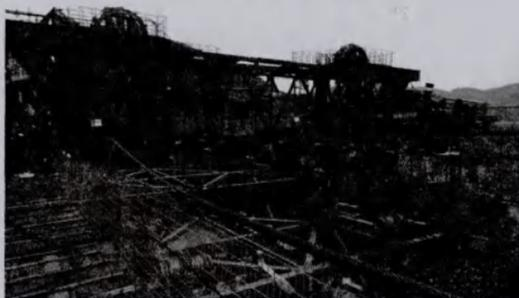
图17 轨索运梁与吊机提升系统架梁
