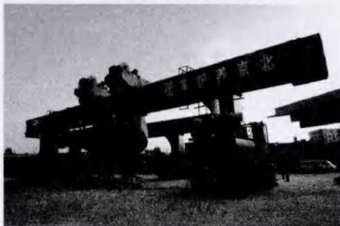
图8 液压提梁机在工地作业
