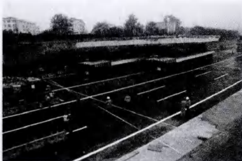
图7 驮运旧桥至临时场地
