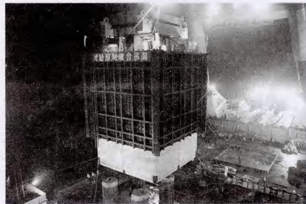
b 吊装试验墩台
