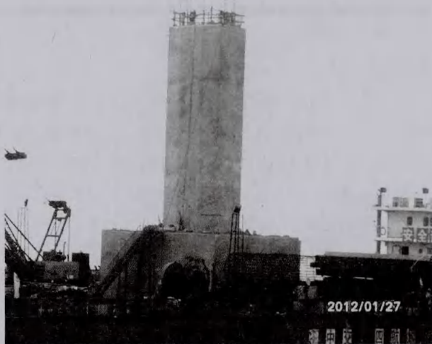
图2 埋置承台足尺试验研究墩台
