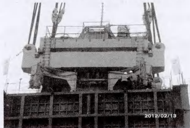
a 安装三维吊具
