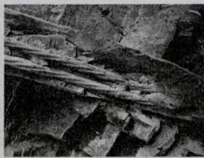
图3 水泥包裹体从钢绞线上脱落
