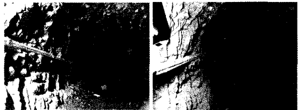
图1 沿着锚孔轴向掘进隧道并直接观察原锚索的情况
