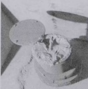
图8 锚杯内填充防腐油脂
