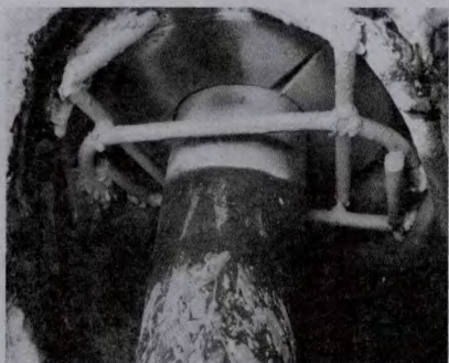
图12 塔端减振器安装
