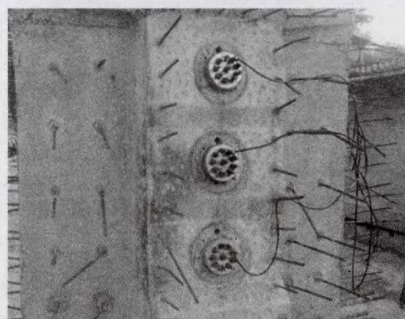
图8 试验梁端部电绝缘锚具导线预埋
