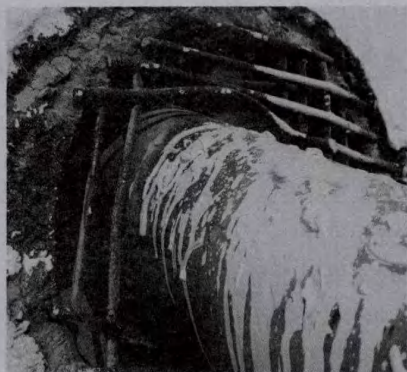
图11 塔端预埋管
