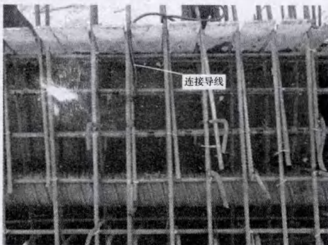
图3 T梁翼缘板导线预埋的检测梁
