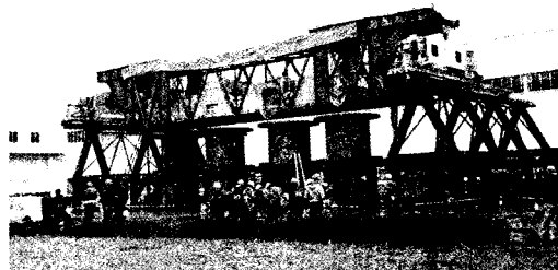
矮寨大桥缆载吊机型式试验现场
