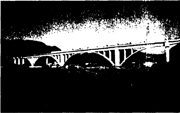
图12 铁路鲤鱼潭桥
