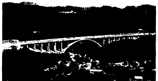
图16 北二高基汐段五号桥
