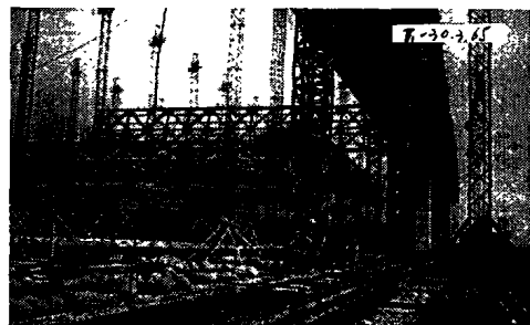
图5 首都机场四机位机库屋盖钢结构提升
