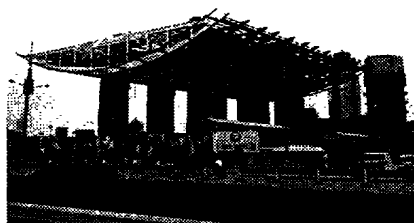
图 8 上海大剧院钢屋架提升
