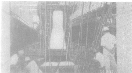
图2 轨道梁钢筋网架
