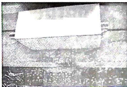
图4 设计其中一个梁托支撑体外索
