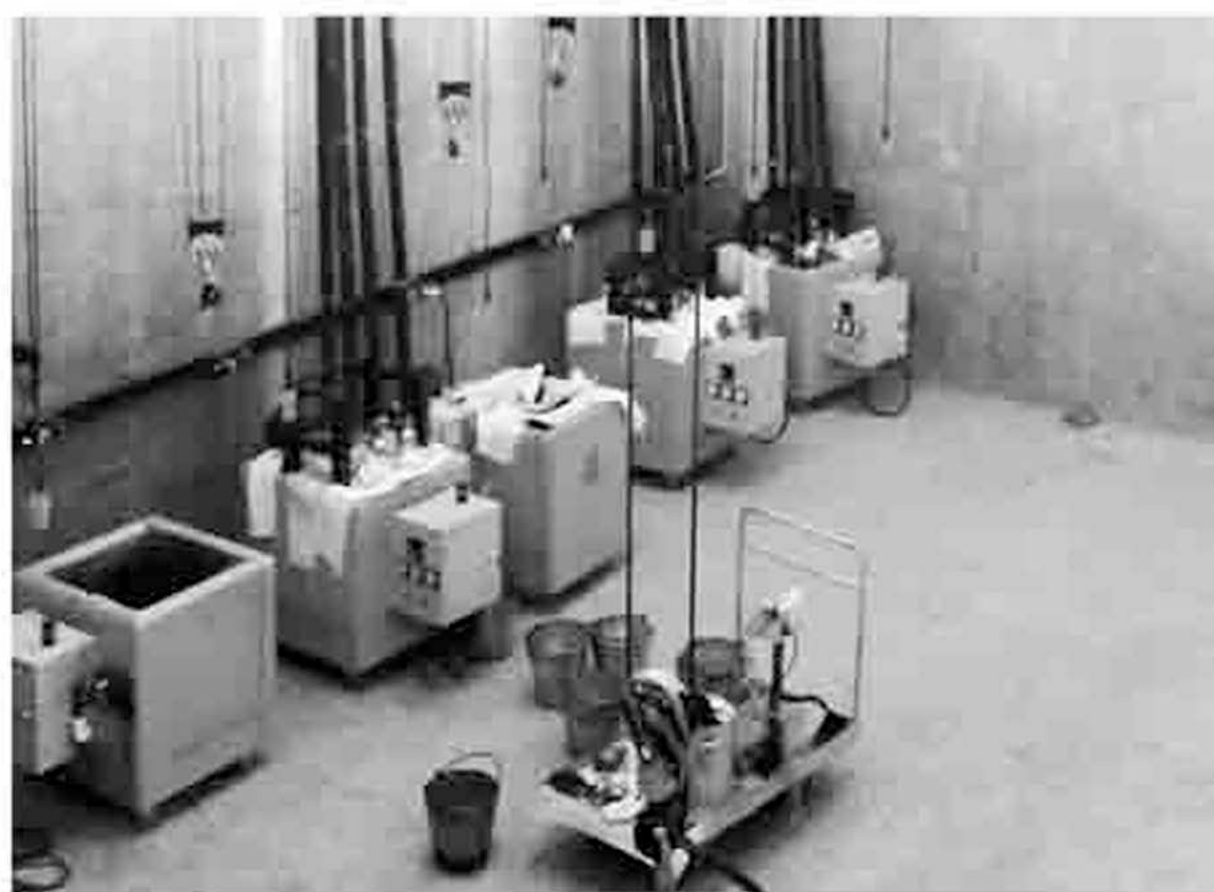
图9 现有制锚装置
