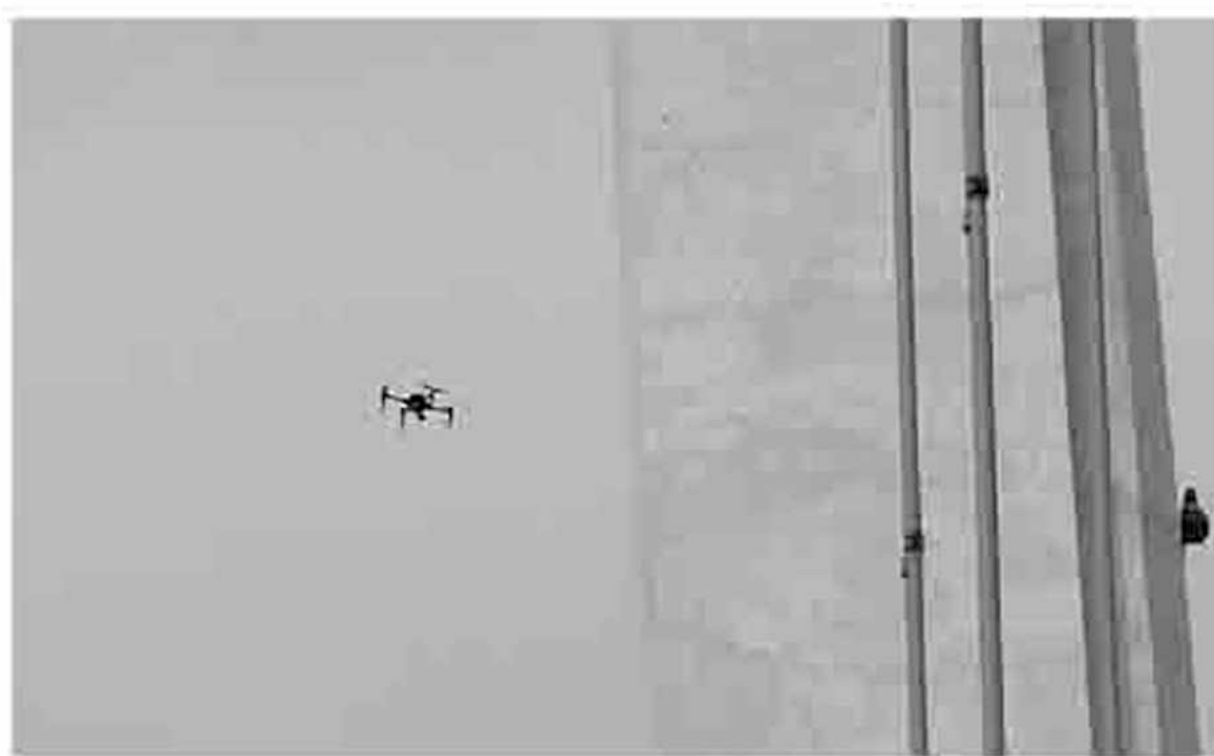
图4 无人机检测桥塔
