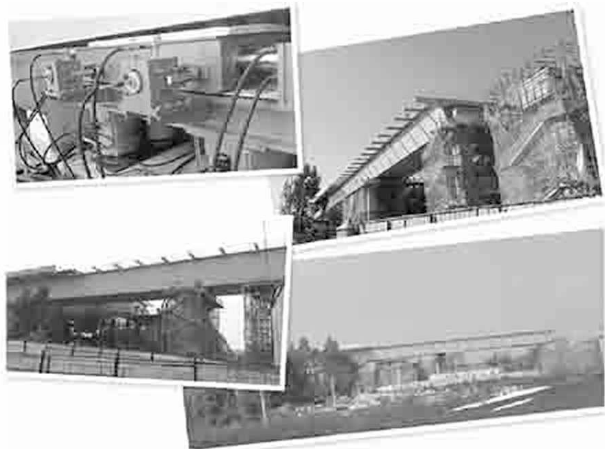
图5 步履式顶推系统施工现场图
