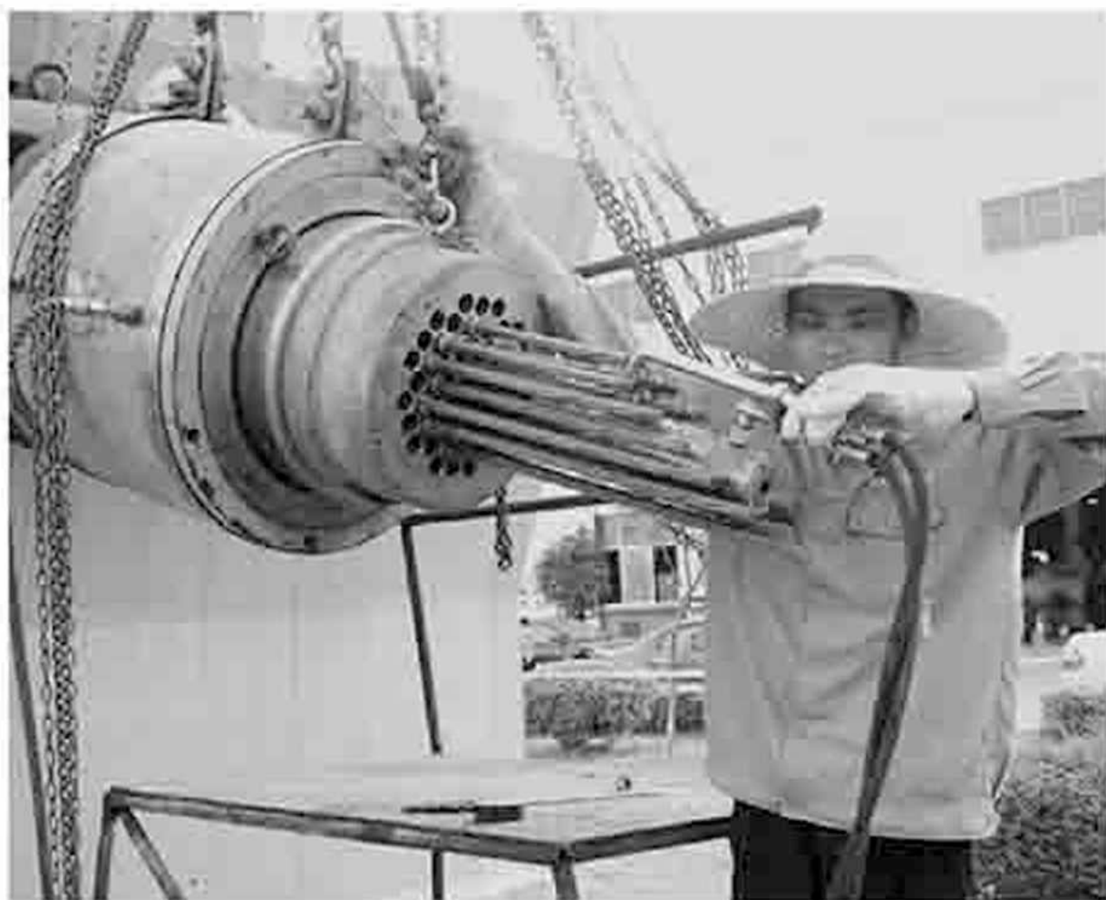
图9 张拉锚固更换后的钢绞线
