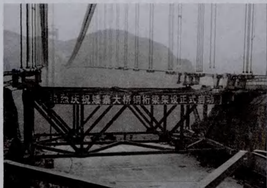
图20 运梁小车运梁
