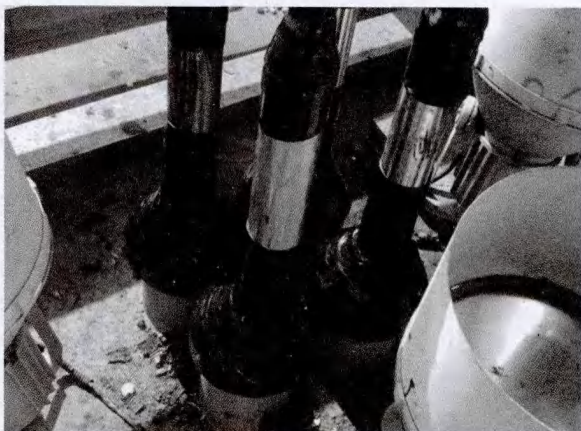
图17 维护后的吊索下部外观
