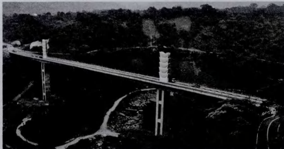
图13 台湾小半天矮塔斜拉桥竣工
