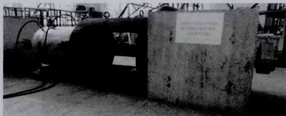
图8 55孔索鞍与混凝土的粘结性能试验图
