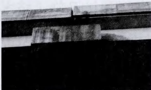
图3 右幅第二联6#墩偏位情况
