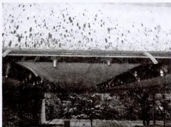
图4 注胶及排气管安装
