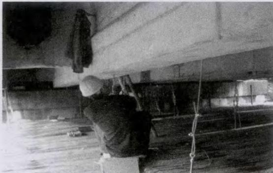
图2 植筋钻孔
