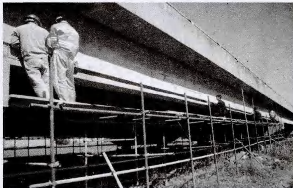
图7 现场碳纤维板试装
