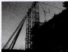
图6 门式提升塔架 立面现场照片
