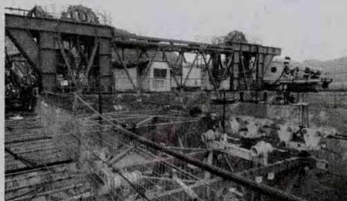
图17 轨索运梁与吊机提升系统架梁
