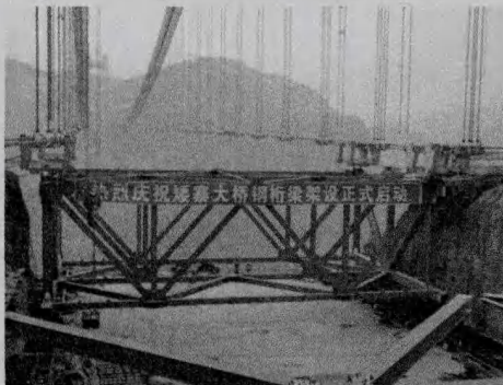
图16 运梁小车运梁
