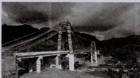
图1 施工中的LEINLI悬索桥
