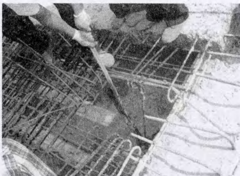
图5 将连接索吊下施工面
