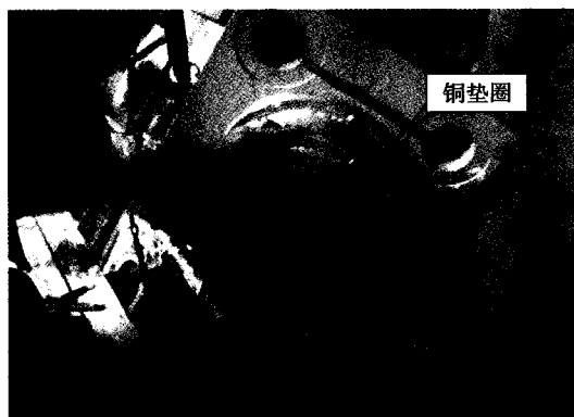
图7 铜垫圈安装
