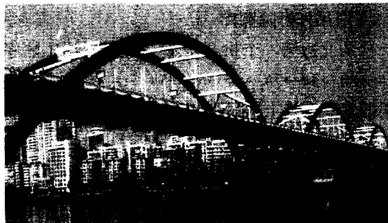
图6 更换吊杆后的柳州文惠桥
