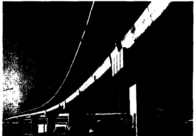
图4 四丰桥1#匝道全景
