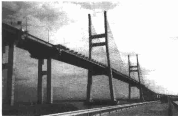
图1 雄伟的西海大桥
