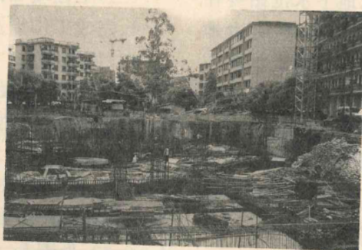
照片 1:箱型基础钢筋混凝土施工标高达正负零
